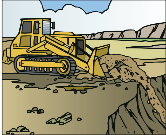
Das abgekippte Material ist mit Erdbaumaschinen – am sichersten mit einer Planierraupe – abzuschleppen.
