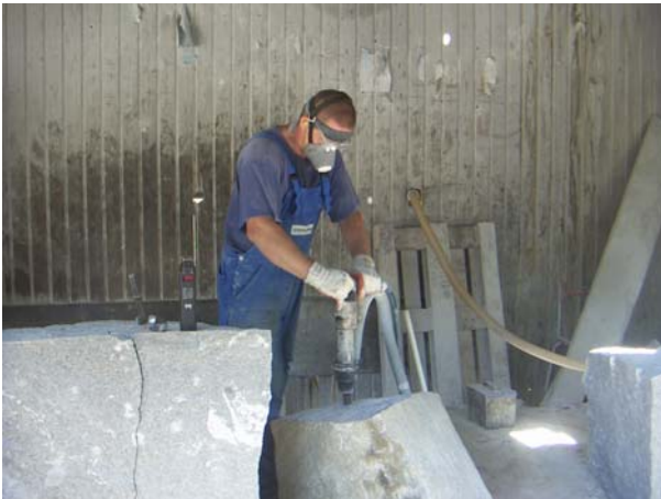
Bilder 2, 3: Keillochbohren im Arbeitsbereich Spalter
