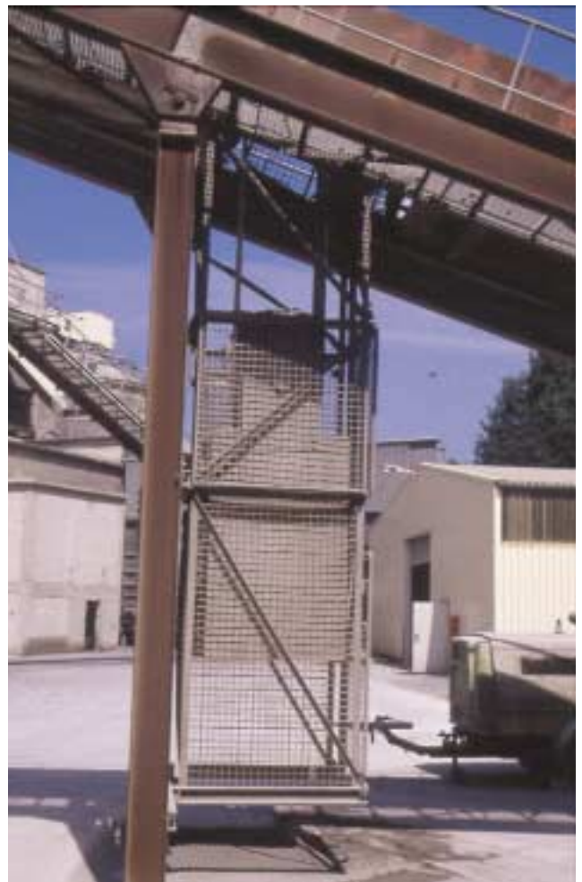
Abb. 17: Verdeckung einer Spannstation
