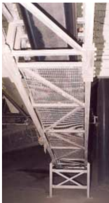
Abb. 21: Vollständige Verkleidung über einem Verkehrsweg
