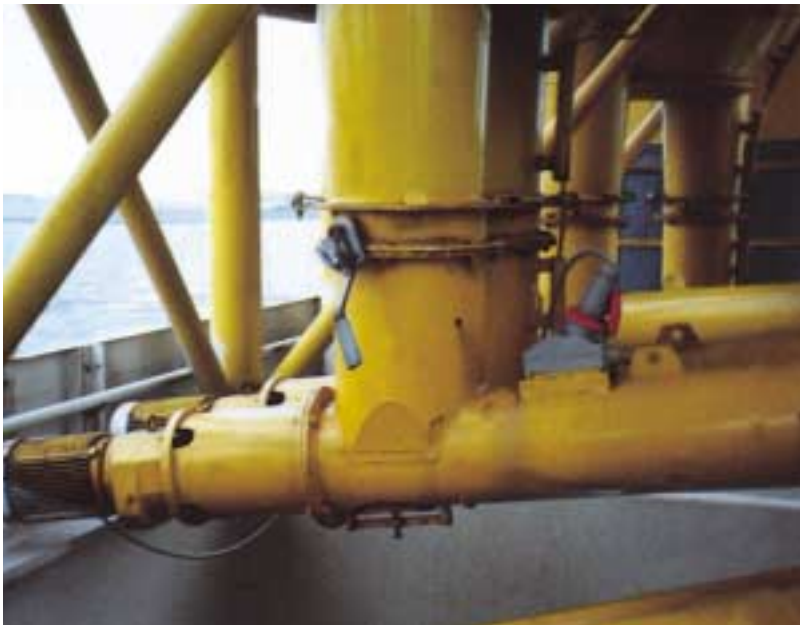
Abb. 41: Allpolige Trennung durch Steckvorrichtung
