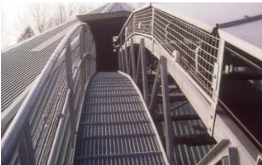
Abb. 15: Seitliches Schutzgitter an einer Bandabknickung
