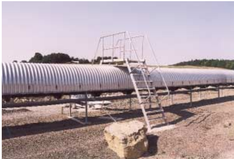
Abb. 47: Sicher zu überqueren durch den Laufsteg
