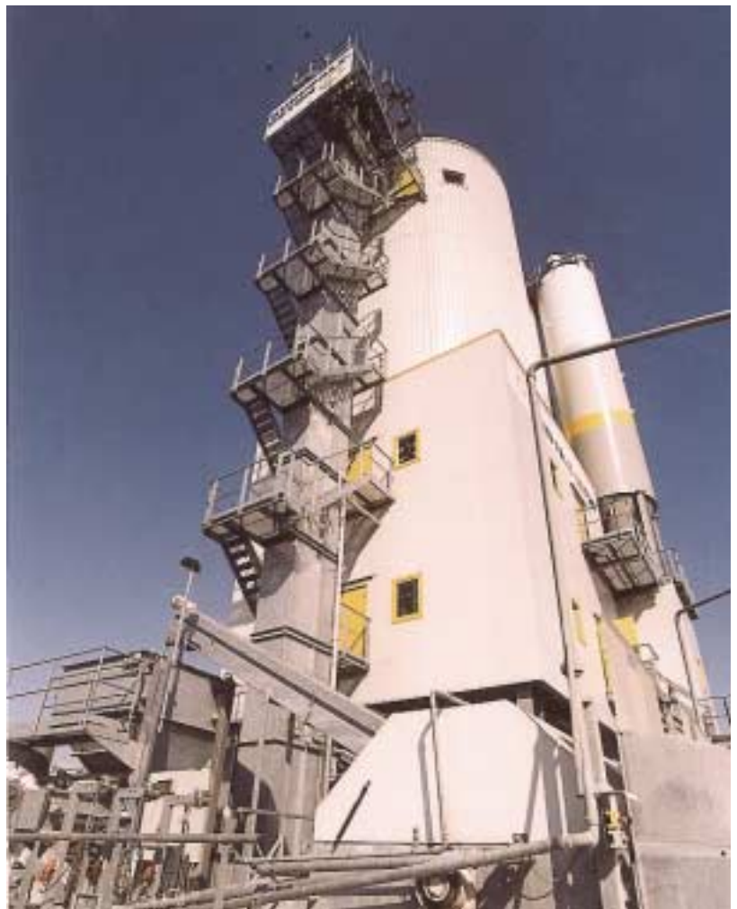
Abb. 37: Treppenaufgang um das Becherwerksgehäuse
